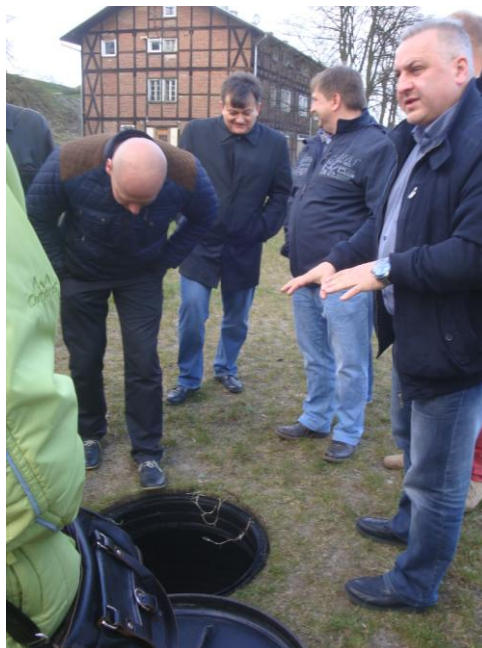
Foto: Centrum Hewelianum w Gdańsku - oglądanie wybranych instalacji dolnych źródeł ciepła
